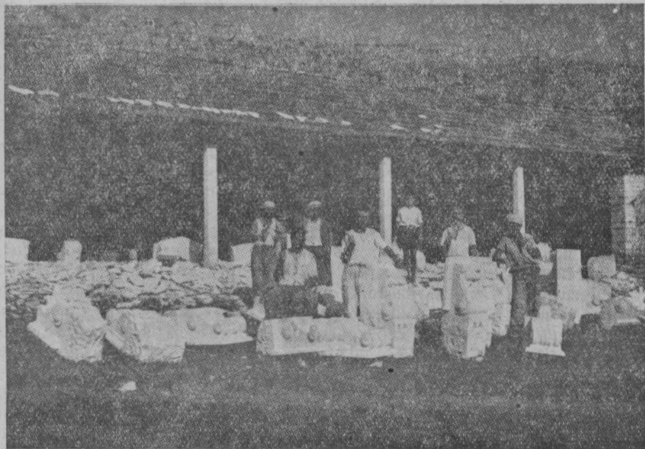
Фиг. 13. Работници-каменоделци изработват „на чисто“ конзолите за Дома на БКП и Земедельският дом в София. При лошо време работата се извършва под изградения от народната власт навес
